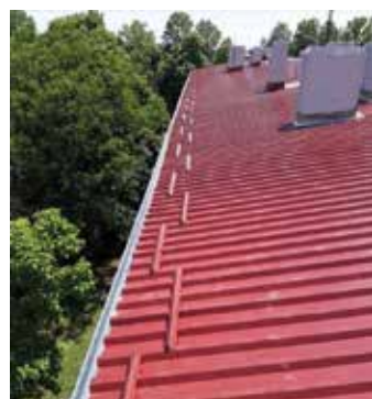
U Savskoj ulici 1 i 3 ovako je rešen problem ravnog krova
